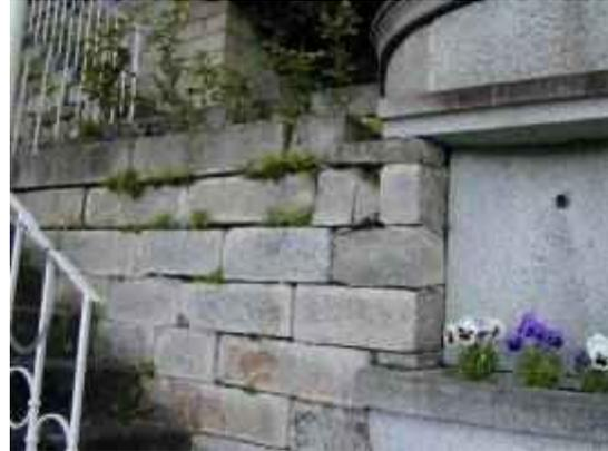
Abb. 32: Trockenmauer aus behauenen Granitquadern mit gut ausgebildeter Fugenvegetation; Faustschlössl, Aschach an der Donau
