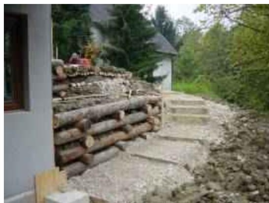
Abb. 30: Krainerwand aus Lärchenholz als Böschungssicherung.
