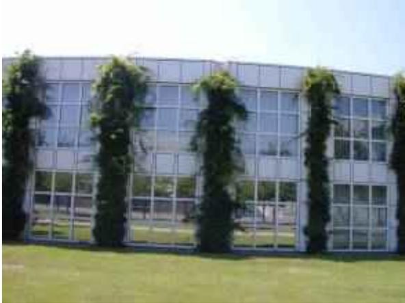
Abb. 22: Schlingpflanzen an Drahtseilen zur Gliederung einer strengen Fassade.
